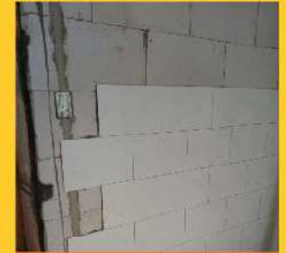
Dán gạch lên tường bê tông nhẹ ALC
