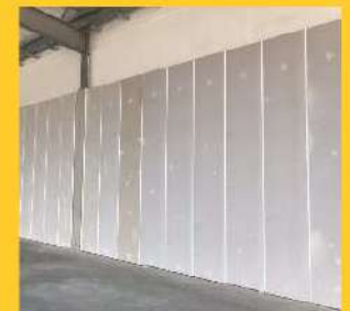
Lắp tường tấm bê tông nhẹ ALC
